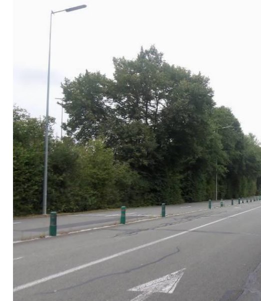
Figure 506 : Eclairage le long des voiries d'accès au Parc (MEDIATERRE Conseil, 2019)
