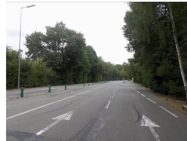
Figure 395 : Voirie au sein du Parc Astérix, pour accès aux parkings (MEDIATERRE Conseil, 2019)
