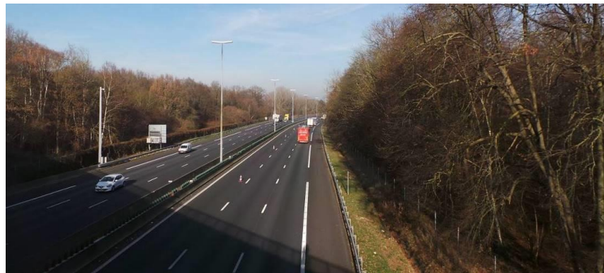
Figure 390 : A1 depuis le pont de la RD118, vue vers le nord (vers le parc) (MEDIATERRE Conseil)
